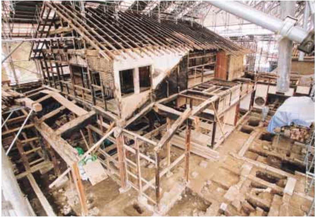
口絵 6 重要文化財旧熊谷家住宅保存修理工事
