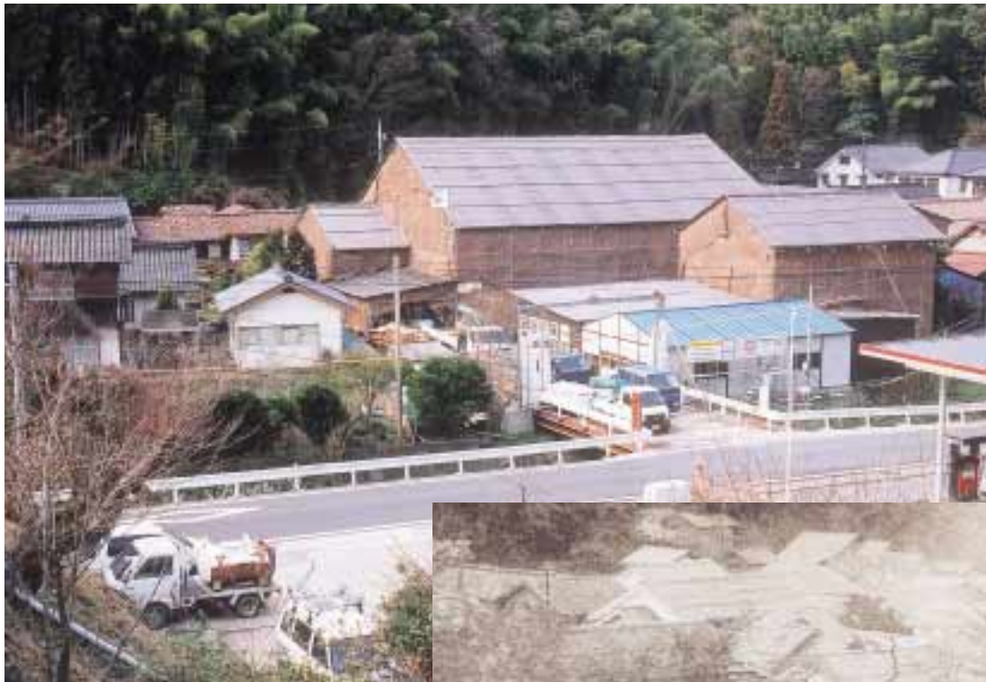
口絵 7 重要文化財旧熊谷家 保存修理現場風景
