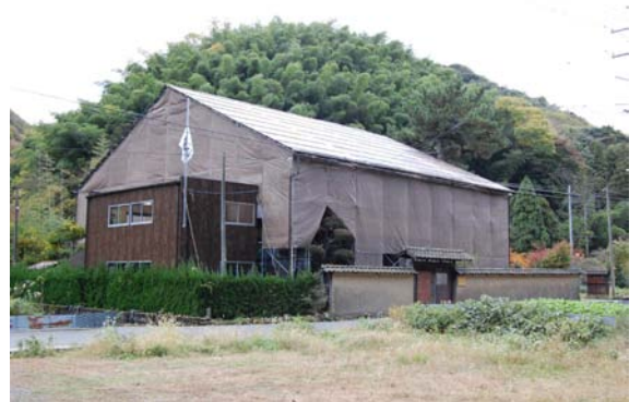
渡辺家住宅工事現場
